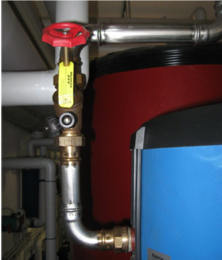
ungedämmte Rohrleitungen
